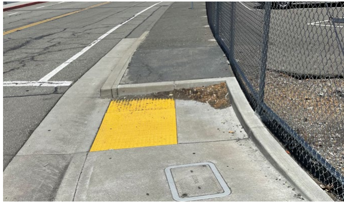
ADA Curb Ramp
