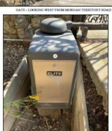
GATE CONTROLLER - NORTH SIDE SWING GATE OPERATOR
