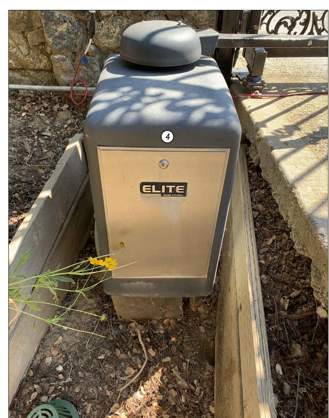
GATE CONTROLLER - NORTH SIDE SWING GATE OPERATOR
